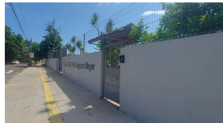
Pintura da parte externa do muro.
