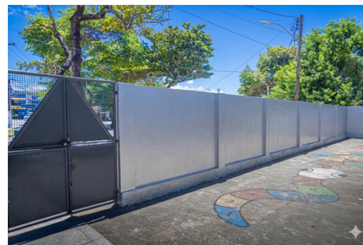
Pintura da parte interna do muro.
